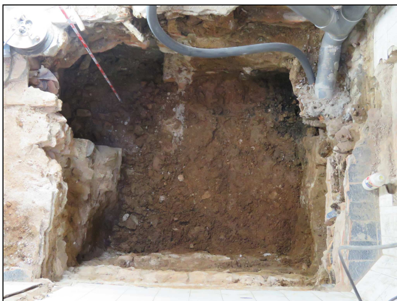
Imatge final de la intervenció arqueològica fins a cota d'afectació
